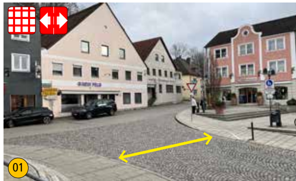
Fehlende Bordsteinabsenkungen, schwer berollbarer Pflasterbelag etc. erschweren die Querung des Oberen Marktplatzes
