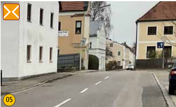
An der Einmündung Weg/„Gassl“ auf die Untere Hauptstraße ist der Abbiegeradius eng sowie der Fußweg sehr schmal
