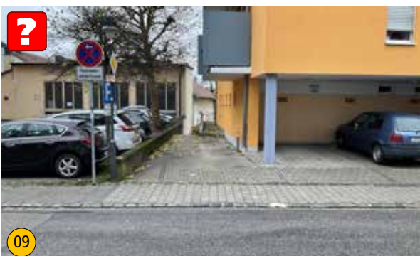
Verbindung zur Unteren Hauptstraße. Die alternative Wegeverbindung für Menschen mit visuellen Einschränkungen ist nicht direkt auffindbar.
