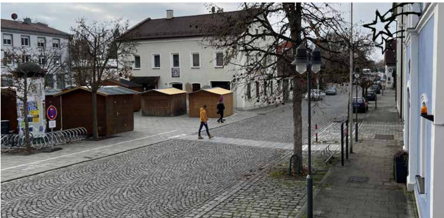
Marktplatz: unterschiedliche Materialien, schwer berollbares Kopfsteinpflaster und Querung mit Mängeln
