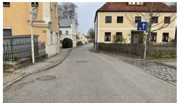
Hochborde und Engstellen im Bereich der Unteren Hauptstraße (bereits außerhalb des Untersuchungsgebietes). Hier ist nur eine Gehwegseite nutzbar. Eine Querung ist nicht möglich
