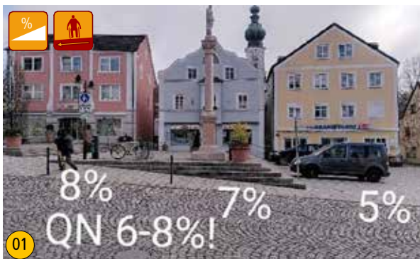
01 Marktplatzfläche mit Stufenanlage, Gehweg mit großem Längs- wie Quergefälle (6-8%)
