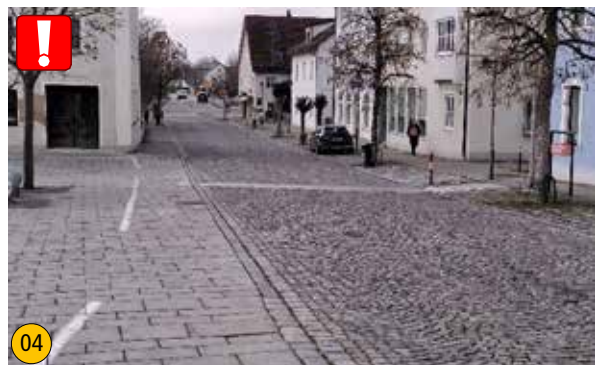
04 Parkplatz mit Kfz-Verkehr ist nur optisch von den Gehbereichen abgetrennt
