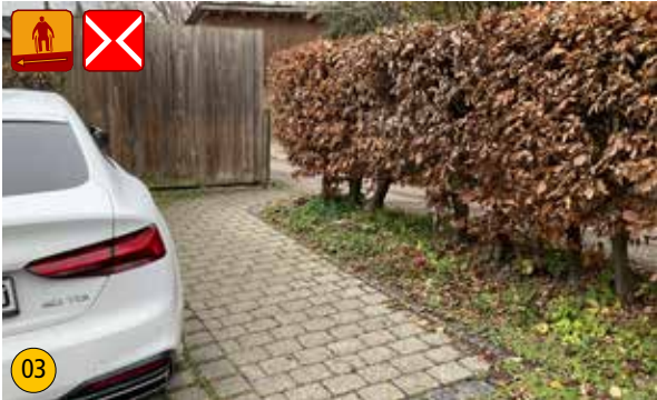
Der Durchgang zum „Gassl“ ist sehr schmal und hat sowohl Quer- als auch Längsgefälle (jeweils ca. 6 % ). Für Richtungswechsel ist nur wenig Fläche vorhanden
