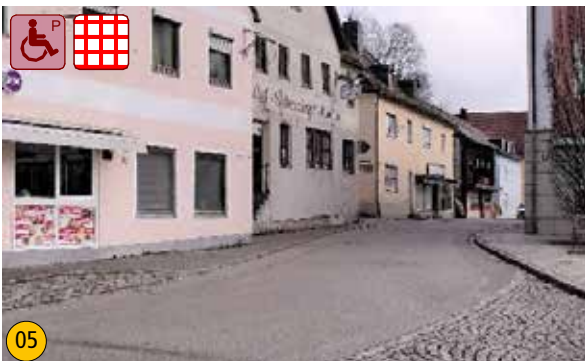
05 Oberfläche des barrierefreien Stellplatzes ist durch die breiten Fugen schlecht berollbar
