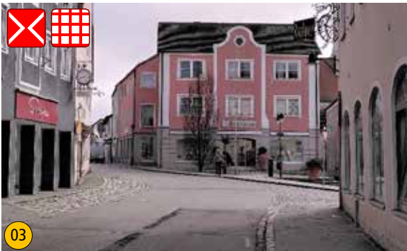
03 Starke Einengung des Gehwegs auch durch einen Straßenbaum und die unebene Einfassung
