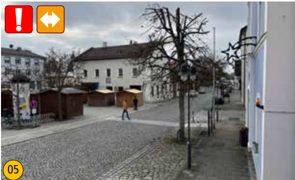
„Furt“ aus berollbarem Plattenbelag, jedoch mit gefährlichem Gefälle zur Fahrbahn („Stop“-Feld). Fahrbahnkante für Blinde schwer wahrnehmbar
