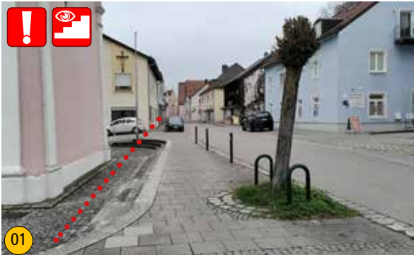
01 Ungesicherte, nicht markierte Stufen im Gehwegbereich: nicht nur für Sehbehinderte und Blinde ist dies gefährlich - Sturzgefahr
