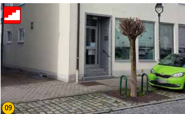
Zugang Arztpraxis über mehrere Stufen
