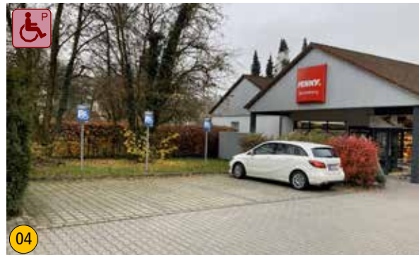
04 Die Behindertenstellplätze am Discounter sind nach Norm zu schmal markiert
