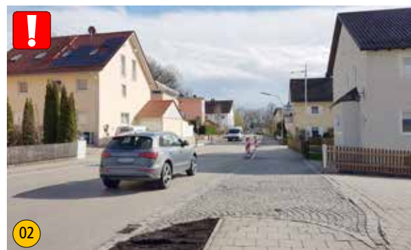
neue Bushaltestelle nur jeweils von der anliegenden Seite aus barrierefrei erreichbar
