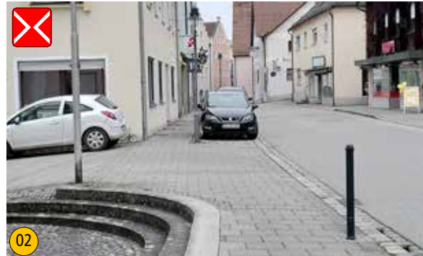
02 Die Treppenanlage schränkt die Gehwegbreite stark ein; zusätzlich verringern die vorhandenen Poller gegen Falschparker die Gehwegbreite noch weiter
