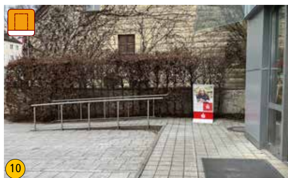
Zugang Bank über Rampe. Aufsteller behindert die für den Richtungswechsel notwendige Fläche
